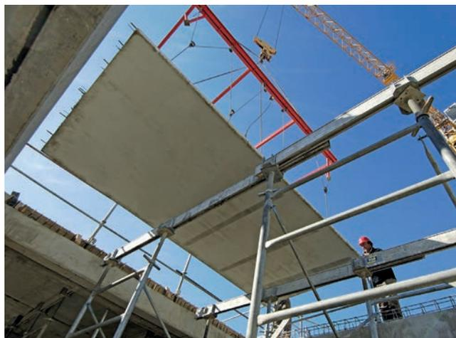
Avant la livraison, le Bureau d'Etudes Rector réalise le calepinage des rupteurs thermiques et des prédalles puis transmet un plan de pose à l'entreprise de gros œuvre. Ce plan donne toutes les indications pour réaliser le plancher dans l'ordre et le sens d'avancement préalablement mis au point avec le responsable du chantier.
