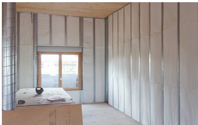
Isolation des murs et cloisons
